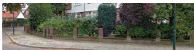
Originele houten hekwerkjes vervangen door metselwerk met stalen buis (Plein 1918)
