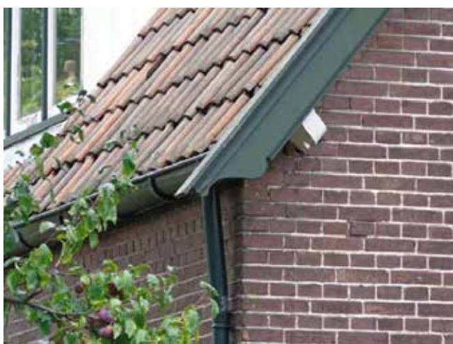
Gedetailleerde windveer met dekljst (periode 1911-1925)
